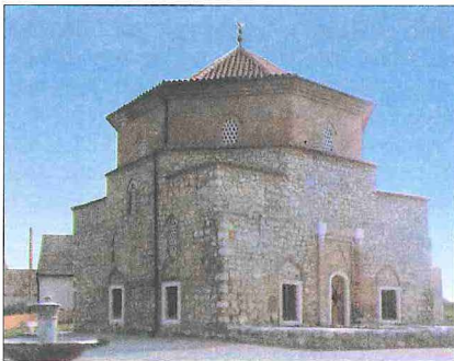
Malkoç Bey Camii - Şikloş / Macaristan
